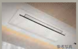
天井カセット式エアコン 圧迫感がなく部屋をスッキリ広く見せる効果があり、細やかな空調も設定できます。
